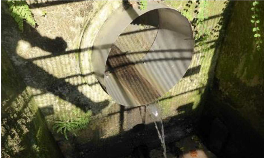
Abbildung 18 Beispiel Krebsperren im Rohr (Quelle Modellprojekt Krebsperren zum Schutz von Dohlenkrebs und Steinkrebsbeständen)
