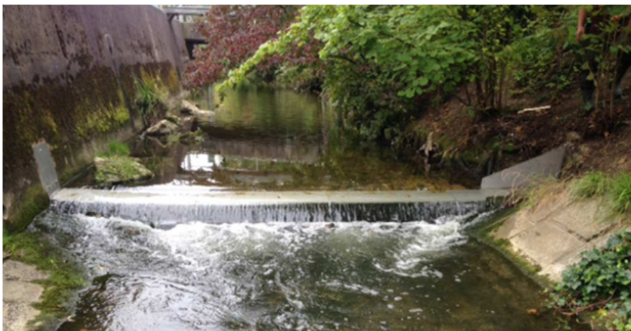
Abbildung 17 Beispiel Krebsabsperren im Bach (Quelle Krebsperren: Feldversuche in einer Fischtreppe, einem natürlichen und einem verbauten Gewässer)
