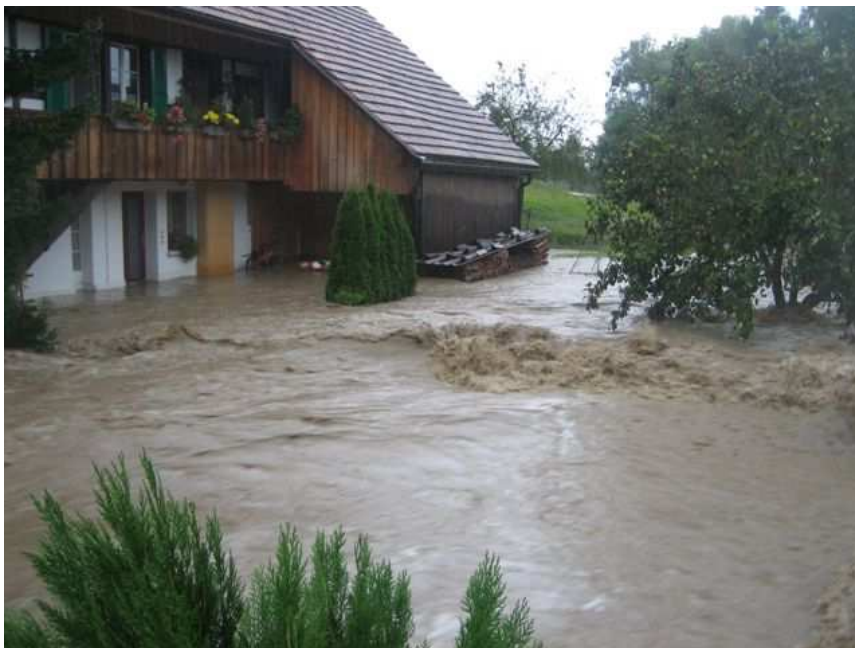
Abbildung 5: Liegenschaft Mühlegasse 9, Blickrichtung Norden
